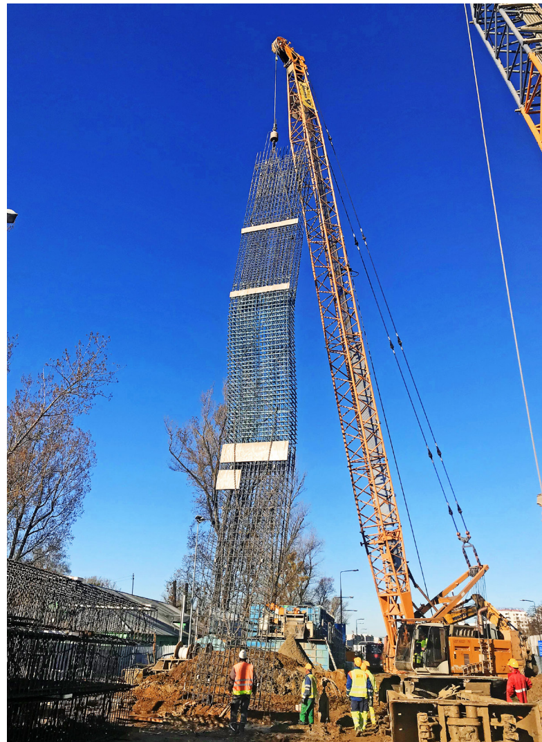
Ryc. 3. Montaż kosza zbrojeniowego z prętów stalowych oraz GFRP w miejscu przejścia tarczy TBM przez ścianę korpusu stacji
