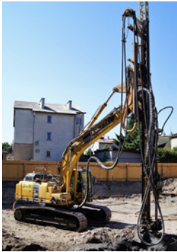
Wykonywanie poziomej przesłony przeciwfiltracyjnej [3]
