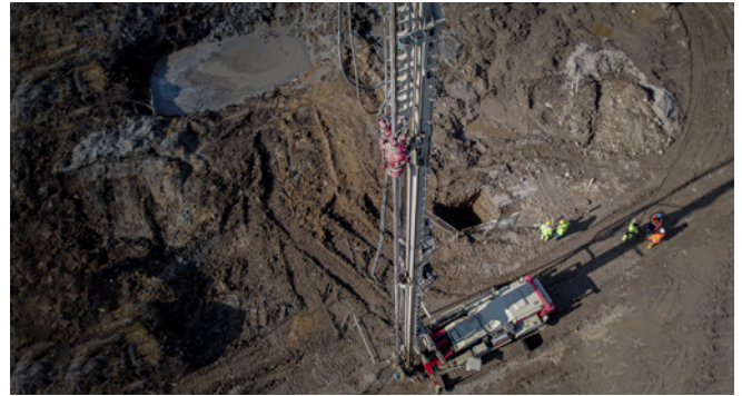
Wykonywanie pionowej przesłony doszczelniającej [3]
