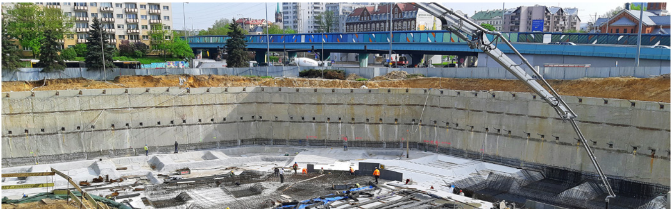
Ryc. 6. Kotwy podwodne – os. Bliska Wola w Warszawie
