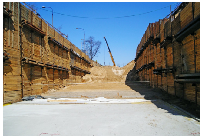
Ryc. 4b. Kotwy tymczasowe – obudowa berlińska tunelu Krakowskiego Szybkiego Tramwaju
