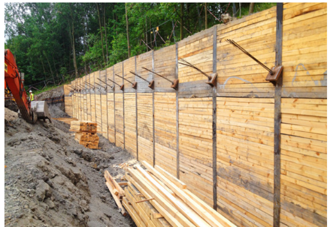
Ryc. 4a. Zabezpieczenie wykopu hali Böhler w Mysłowicach
